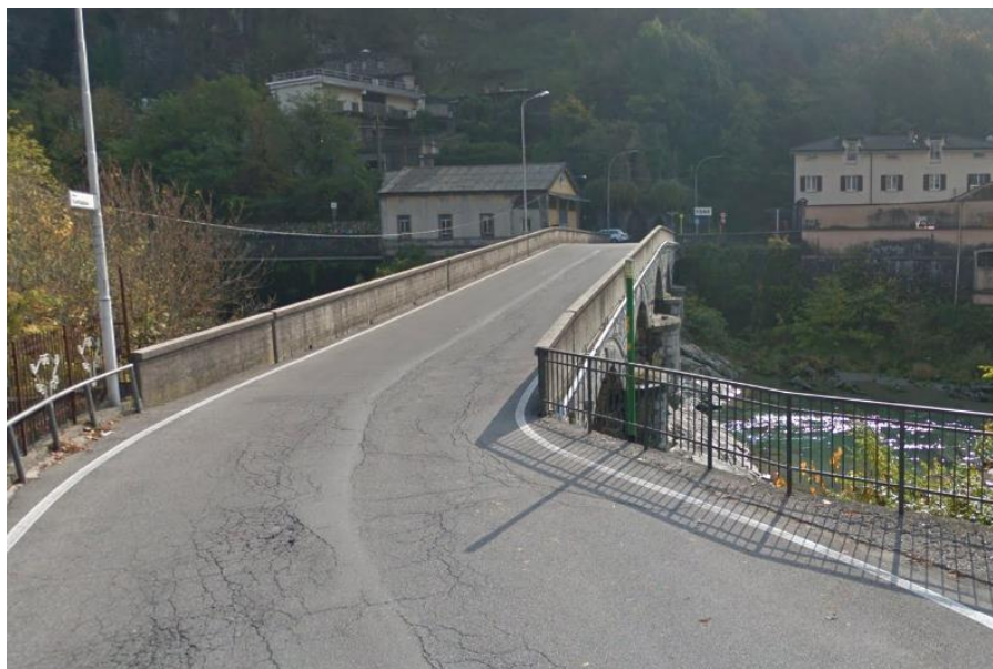
Figura 2 - Gazzaniga, ponte principale di accesso al paese lungo Via Pedignela
