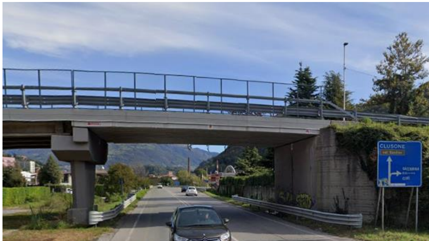
Figura 7 - Gazzaniga, sovrappasso di via IV Novembre (visto dalla SP ex SS 671)
