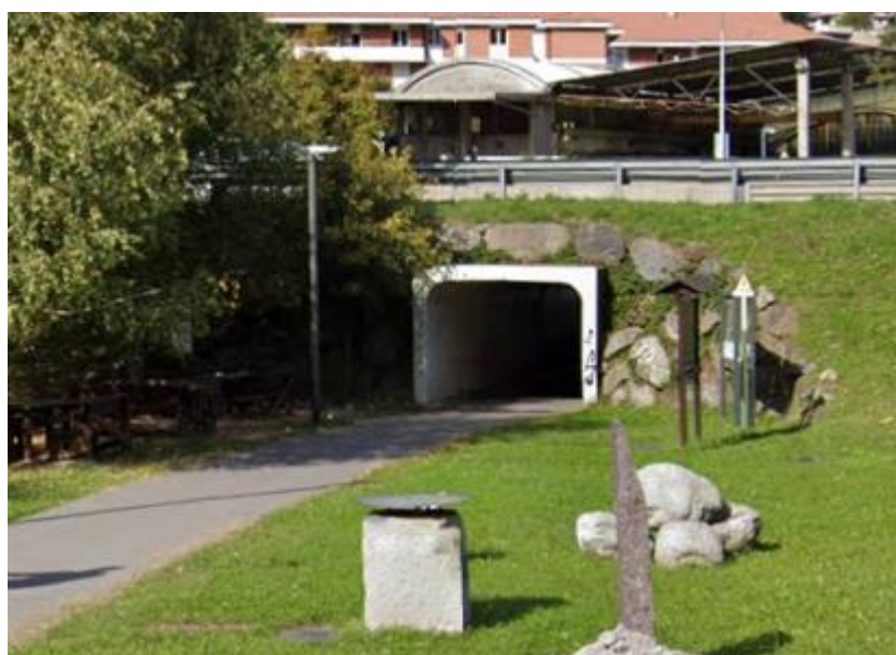
Figura 5 - Gazzaniga, sottopasso ciclabile (zona via Dante)
