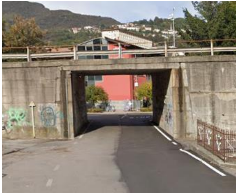
Figura 6 - Gazzaniga, sottopasso di Piazzale Costituzione
