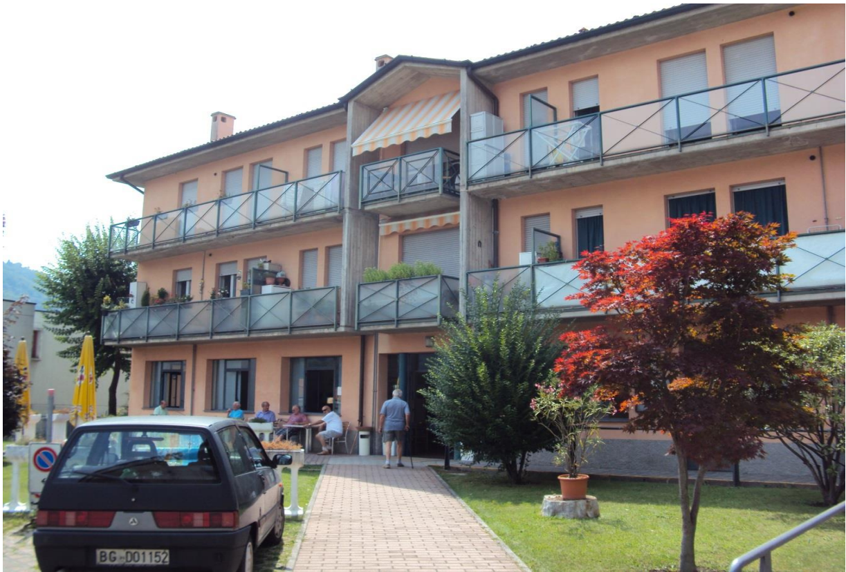
vista da cortile interno
