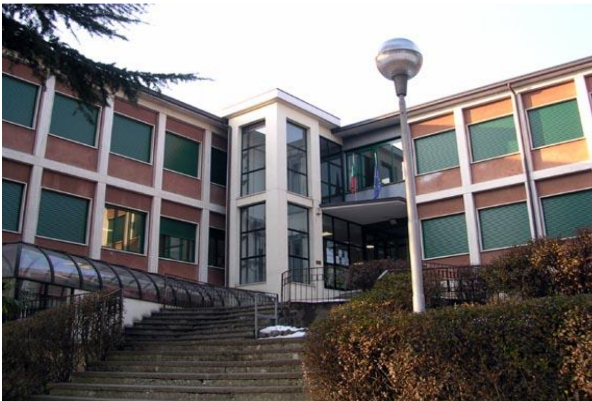
vista da cortile interno
