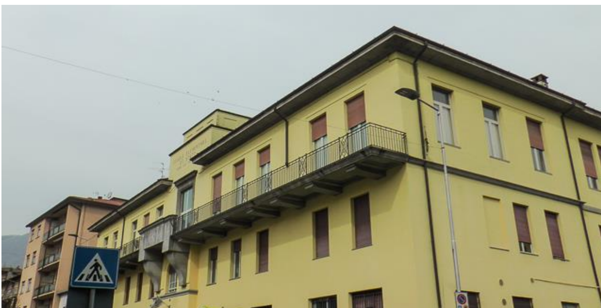
vista da via Marconi
