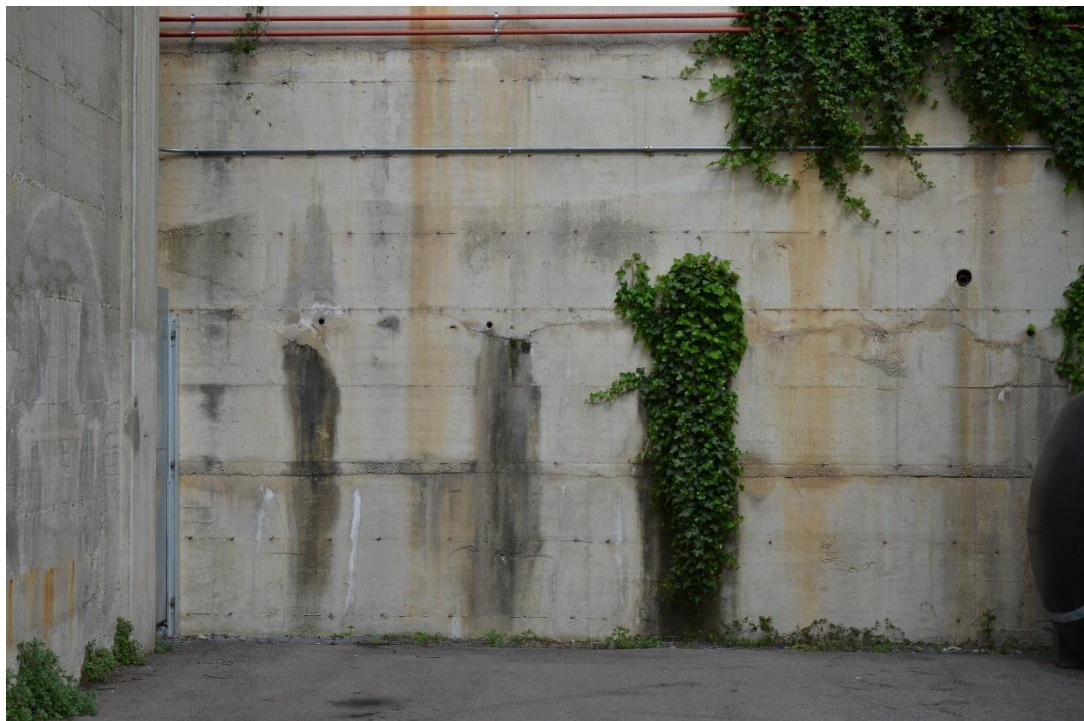
Muro di contenimento
