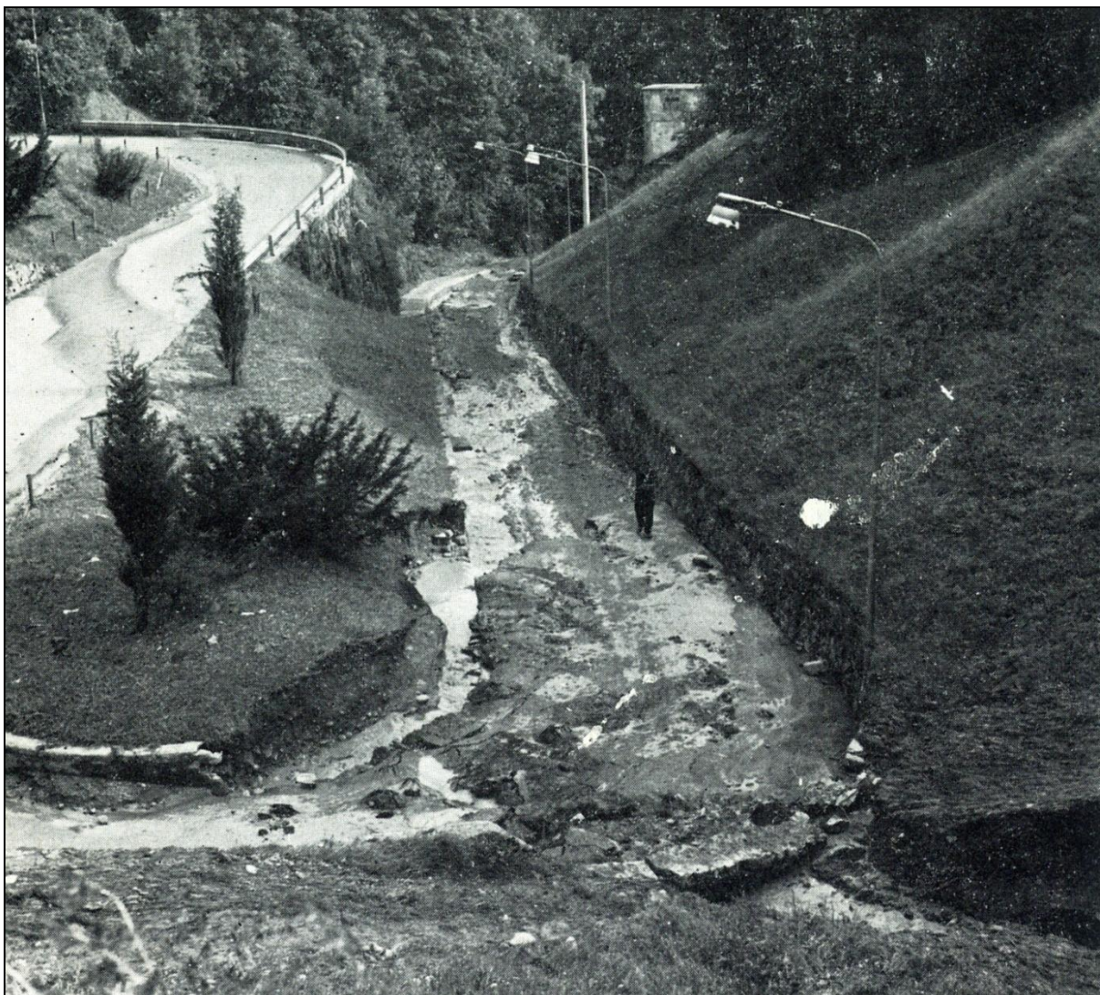
Figura 34 - Tratto alluvionato della Valle Orezzo all'altezza del cimitero di Gazzaniga (1972)
