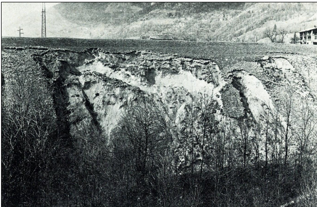
Figura 35 - Smottamenti corticali lungo la scarpata dell'altopiano di Masserini (1972)
