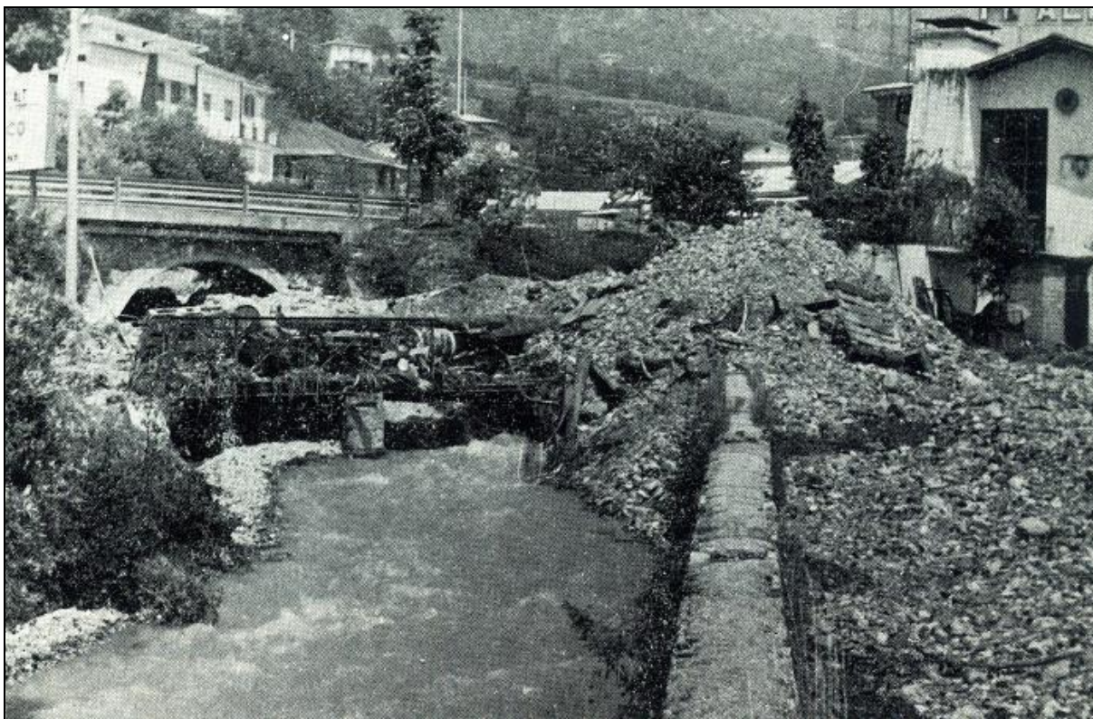
Figura 36 - Esondazione e trasporto solido della Val Rovaro (10 luglio 1972)
