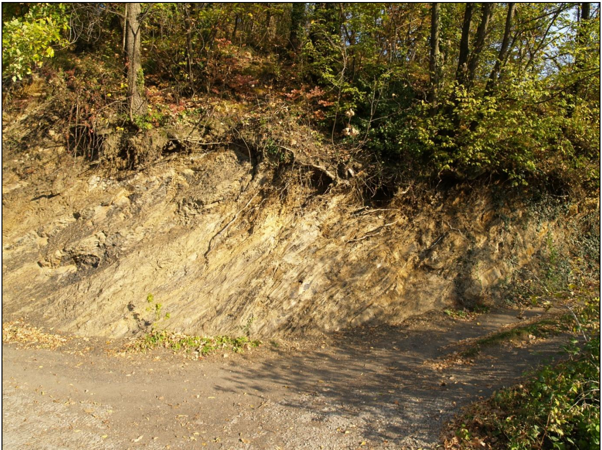
Figura 29 - Affioramento di argilliti tettonizzate in località Mozzo
